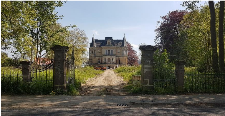
Abb. 4: Zufahrt zur Villa Nordstern von der Itener Straße, April 2020, planerzirkel
