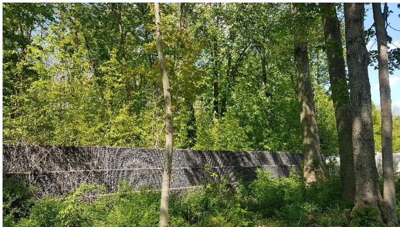
Abb. 5: Gabionenwand entlang der Itener Straße, April 2020, planerzirkel
