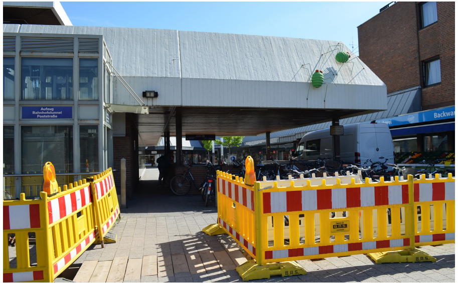
Abb. Nordöstlicher Zugang Bahnhofstunnel mit auskragender Überdachung, Blickrichtung von Poststraße (Quelle: DHP 2022)
